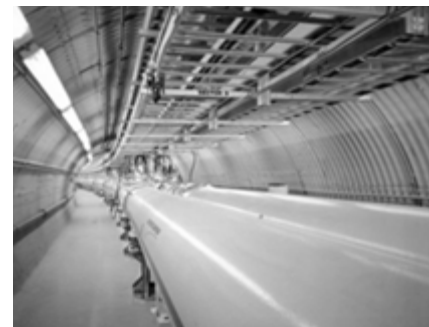
Brookhaven. Tunel urychlovače RHIC uložený necelé 4 metry pod zemí.
