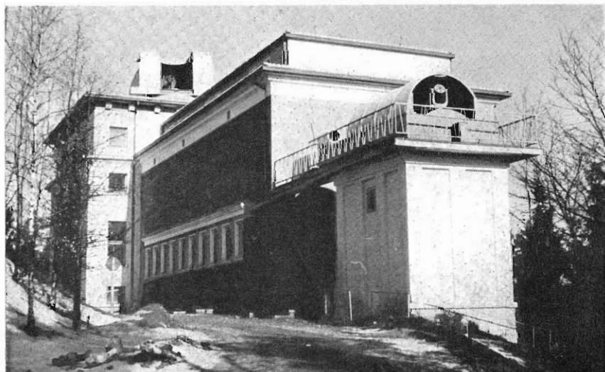
Nahoře coelostat s pomocným zrcadlem. Dole budova sluneční laboratoře. V prvním patře (bez oken) je umístěn spektrograf. Před budovou věž pro coelostat. (K článku na str. 86.)
