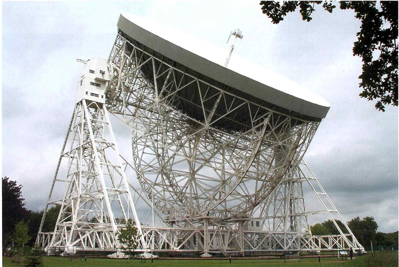
Obr. 2. Obrovská parabolická anténa rádioteleskopu s priemerom 76 m v Jodrell Banku (foto L. Hric).
