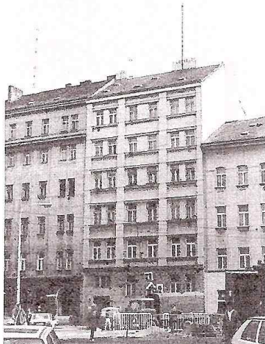
▲ Za okny pátého patra domu v Budečské ulici č. 6 byla do dubna 1993 časová laboratoř, odkud odcházel rozhlasový časový signál. Antény na střeše sloužily k příjmu zahraničních časových signálů.
