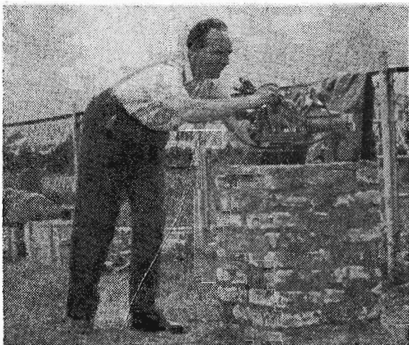
Obr. 2. V. Guth připravuje v Kislovodsku k měření cirkumzenitál. Tento malý a snadno přenosný přístroj pro určování zeměpisných souřadnic z průchodů hvězd určitou výškovou kružnicí byl před léty zkonstruován prof. Nušlem a dr. Fričem. V SSSR byl středem pozornosti nejen sovětskými, ale i zahraničními astronomy, protože se při malých rozměrech svou přesností plně vyrovná klasickým strojům průchodním. Chyba v určení zeměpisné délky je asi 0,01s, v určení šířky asi 0,05".
