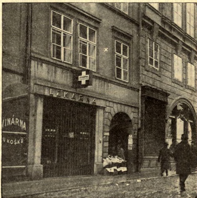
Část průčelí domu čp. 188 ve Velké Karlově ulici v Praze, kde mezi okny I. patra bude umístěna Keplerova deska.
