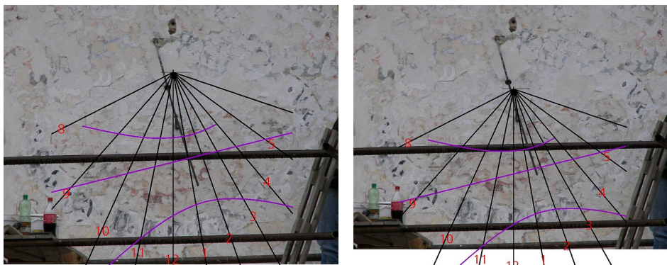
Obr. 6 — Rozmístění hodinových čar pro umístění paty polosu.
