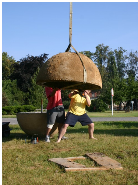
Obr. 23 — Práce jeřábem a rozbrušovačkou.
