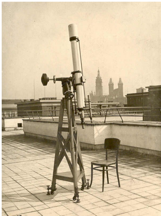
Obr. 4 — Dalekohled ASHK umístěný na střeše Masarykovy školy.
