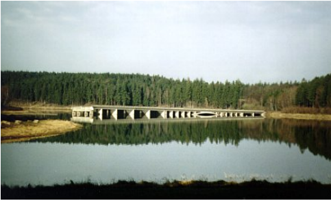
Obr. 10 — Zatopený nedostavěný dálniční most u obce Borovsko (okres Benešov). Jeho délka je 120 m, šířka 22 m a výška téměř 100 m; nad hladinou přehrady Želivka je vidět jen malá část vrcholu oblouku a konstrukce. Most z roku 1942 měl být součástí dálnice z Prahy do Brna, jejíž stavba však byla přerušena válkou. Bližší informace naleznete v [2].
