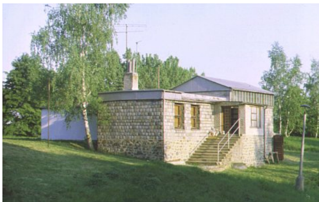
Obr. 6 — Budova výškovské hvězdárny vyfotografovaná od severu. Pod odsuvnou střechou se skrývá dalekohled Newton 300 mm, f/4 se CCD kamerou ST-7, včetně standardních fotometrických filtrů. Foto Miroslav Brož.
